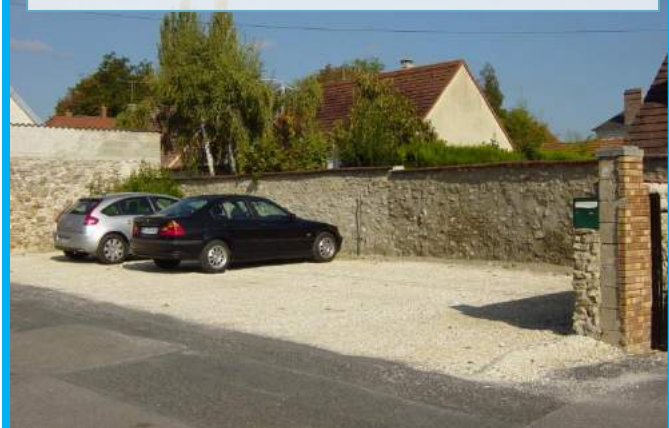
Remise en état du mur, nouveau parking Pierre Legivre
