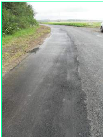
Renforcement par une poutre latérale
