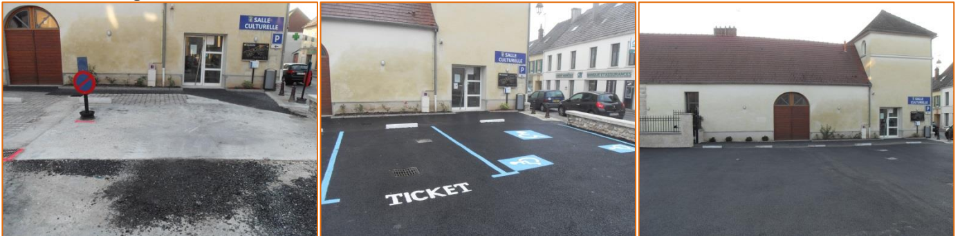
Réfection du parking de la Rue Louis Martin
